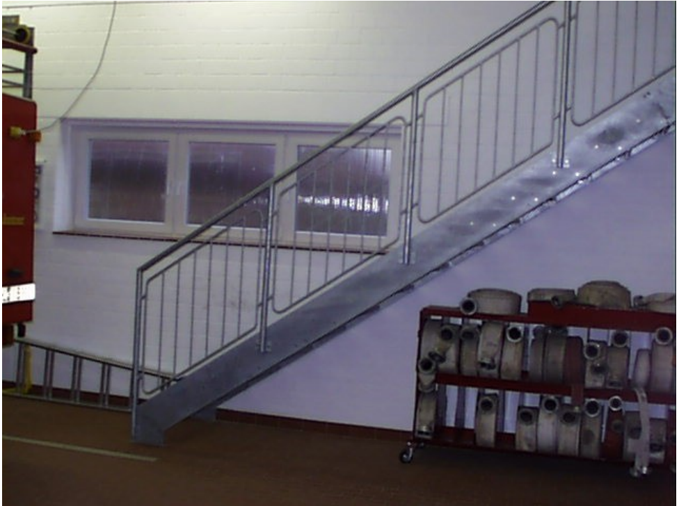
Füllstabgeländer mit korrektem Abstand zwischen den Stäben
