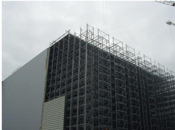
Querschnitt eines im Bau befindlichen Hochregallagers
